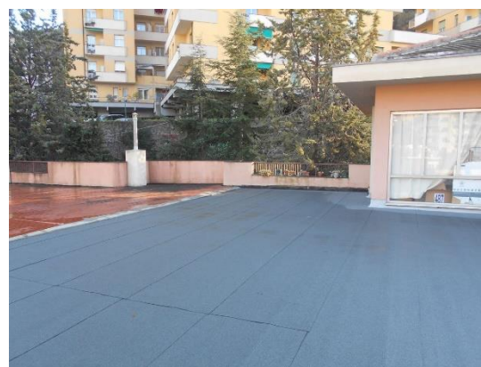
Figura 8.3 - Particolare della copertura del terzo piano
