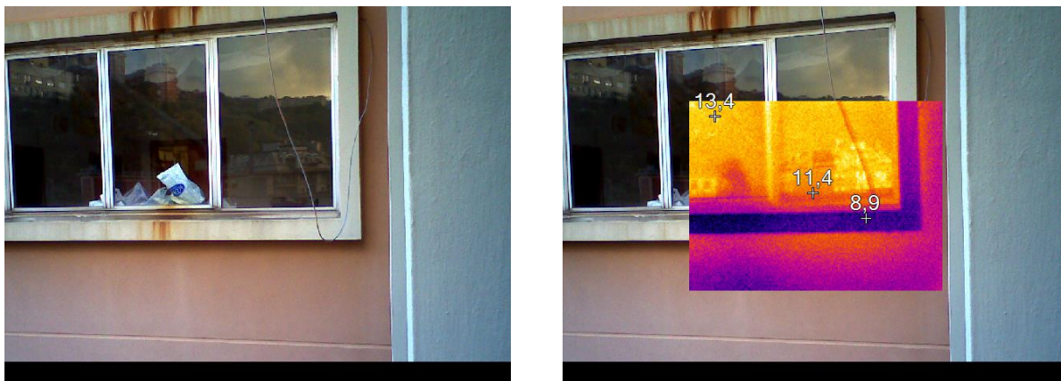
Figura 4.3 – Rilievo termografico della parete
