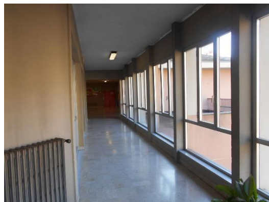
Figura 8.5 - Particolare degli infissi
