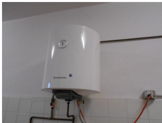
Figura 4.15 - Particolare di un boiler elettrico per la produzione di acqua calda sanitaria
