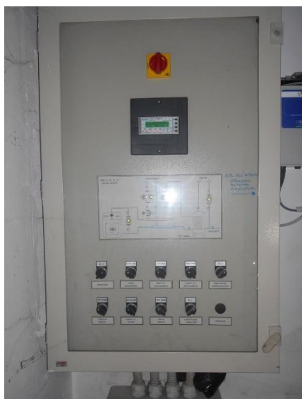
Figura 4.9 - Particolare della centralina di controllo Figura 4.10 – Dispositivi per la telegestione dell’edificio
