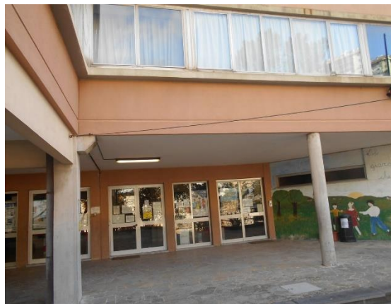
Figura 0.1 - Vista della facciata [esposta a Nord-Ovest]
